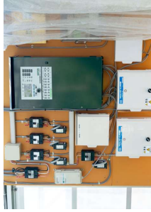
大静ファームでは養液栽培の給液管理システムとして太陽光の熱を蓄積して電源を制御する「自然比例制御」を採用。
