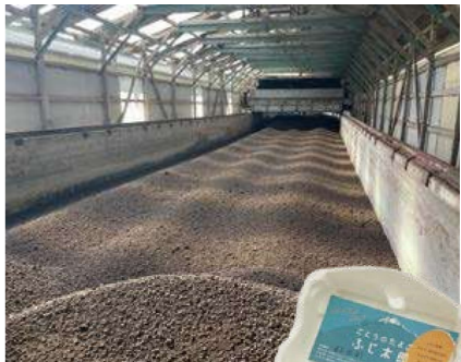
後藤養鶏の鶏糞堆肥製造設備
